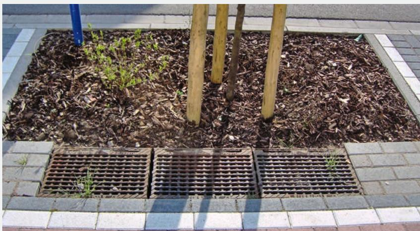
Fig. 4 Adsorbersubstrat in Rinne zur Entfernung von Spurenstoffen, Mineralölkohlenwasserstoffen, Schwermetallen und GUS aus Strassenabwasser, bevor das Wasser in eine Pflanzgrube mit Baum ( $A_E/A_V \geq 5$ ) geleitet wird. (©Fa. Funke Kunststoffe)
