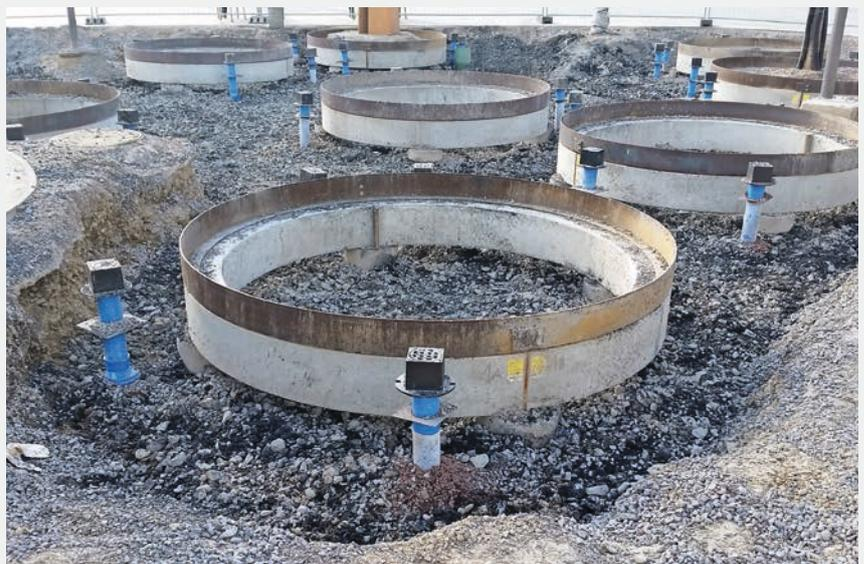
Fig. 5 Eingebautes Pflanzsubstrat mit vor Ort eingearbeiteter roher Pflanzenkohle, Baumbelüftungsrohren und Baumbewässerungswinkeln.
