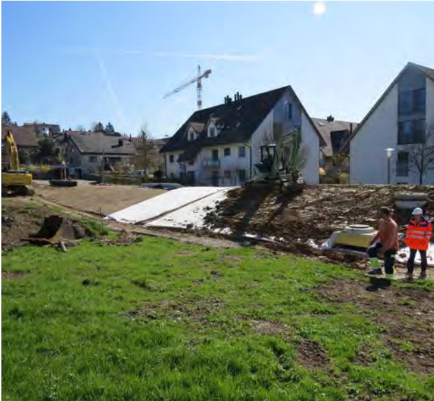
Abb. 24: Erhöhter Damm mit Auslaufbauwerk und hoch liegendem Notüberlauf
