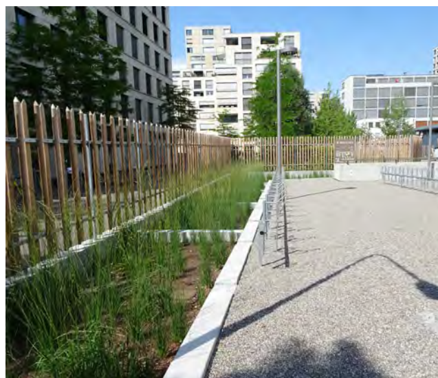
Abb. 59: Offene Gräben für Verdunstung und Versickerung
