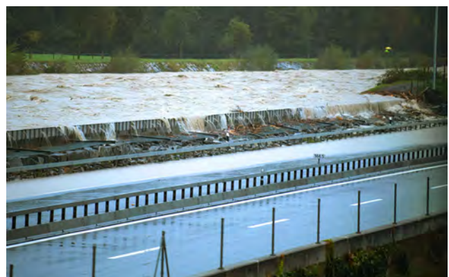
Abb. 92: Flutbarer Abschnitt der Autobahn A2 zwischen Attinghausen und Seedorf (UR) während des Hochwasserereignisses vom Oktober 2020
