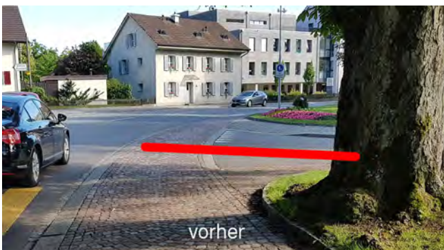
Abb. 32: Schutz der Zofinger Altstadt vor Oberflächenabfluss durch Bombierung der Strasseneinmündung Gefälle vor (Bild links) und nach der Anpassung (rechts)
