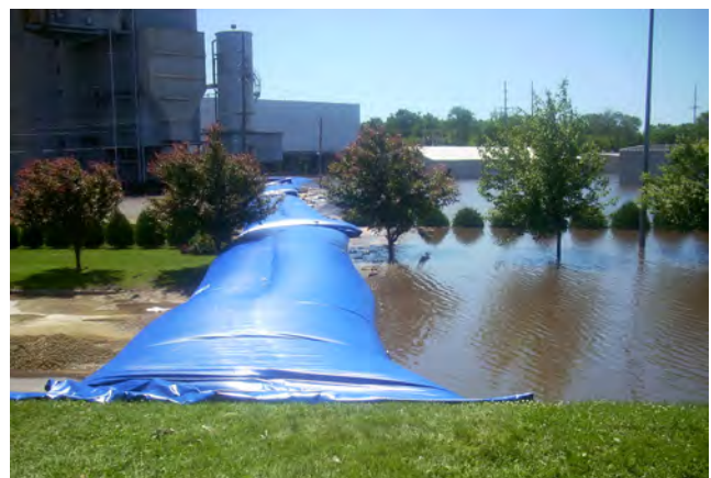
Abb. 93: Mobiler, mit Wasser gefüllter Schutzdamm
