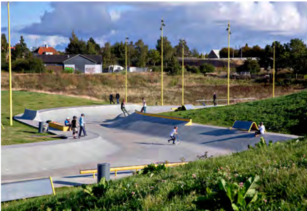
Abb. 85: Verbindungskanal als Skateanlage in Roskilde
