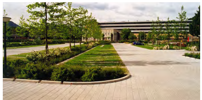
Abb. 39: Beispiel für Rasenfugenpflaster als Parkplatz, Lugano Suglio
