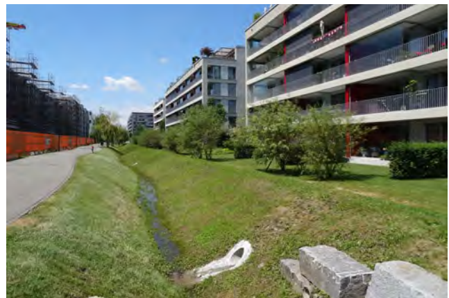
Abb. 57: Gräben leiten das Regenwasser der Gebäude zum See im Opfikerpark.
