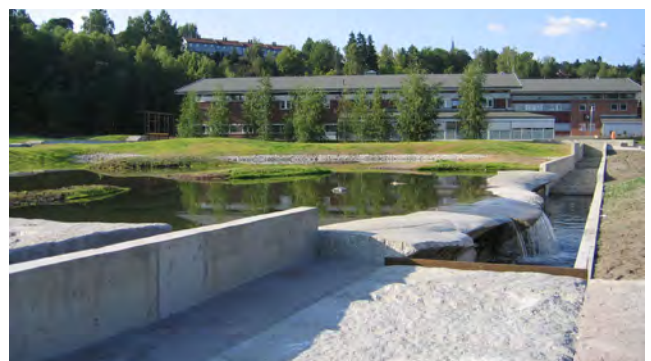
Abb.45: Naturschwimmteich mit Retention und Überlauf
