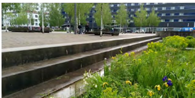
Abb. 53: Bepflanzte Mulden nehmen bei Starkniederschlägen das Wasser am Turbinenplatz auf.
