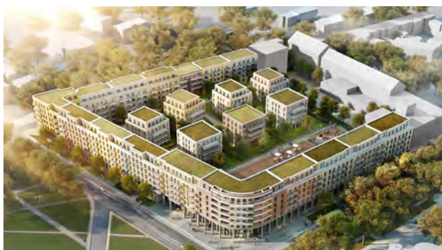
Abb. 75: Dachflächen im Goethequartier in Offenbach
