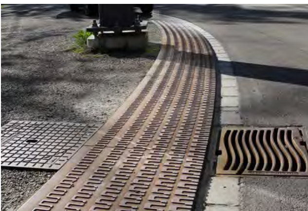
Abb. 87: Platzrand mit 3 cm hoher Überstaukante
