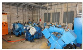
Installierte Kolbenkompressoren in der Medisize AG, welche für die Drucklufterzeugung eingesetzt werden
