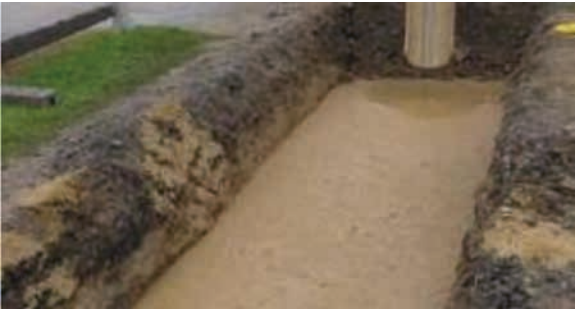
Liquid soil used to fill a ditch https://de.wikipedia.org/wiki/Flüssigboden
