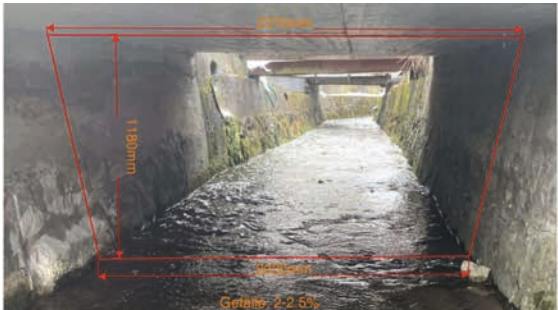
Ausmessung Brückenquerschnitt Eigene Darstellung
