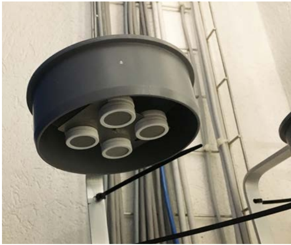
Abbildung 1: Erfassung der Schwefelwasserstoffkonzentration im KWKW mittels Passivsammlern.
