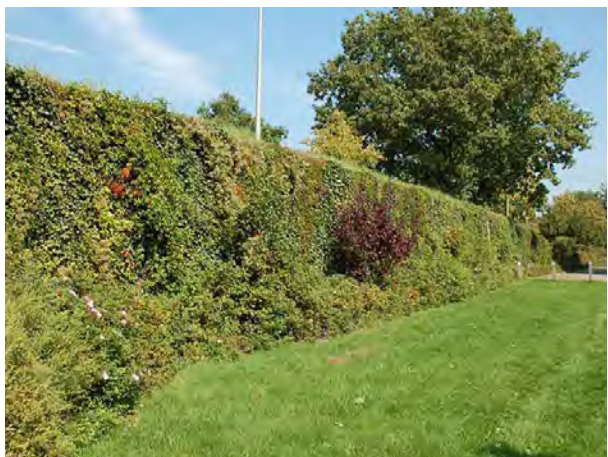
Beispiel für eine begrünte Lärmschutzwand. Quelle: Martin Kettenmeier, Gieselbrecht GmbH, Langen bei Bregenz
