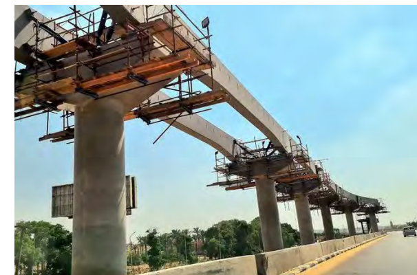
Bau der Monorail-Linien von Giza durch Kairo bis zur New Administrative Capital. Quelle: Simone Stürwald
