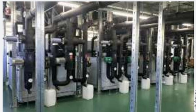
Die drei massgeschneiderten Wasser/Wasser Wärmepumpen vom Typ CTAexklusiv. Der ausbaufähige Maschinenraum bietet Platz für bis zu 8 Maschinen mit einem Endausbau von rund 2 MW Kälteleistung.
