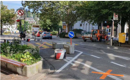
Temporärer Spurrabbau am Oberen Graben in der Stadt St.Gallen als Verkehrsversuch, Tiefbauamt Stadt St.Gallen (2019)
