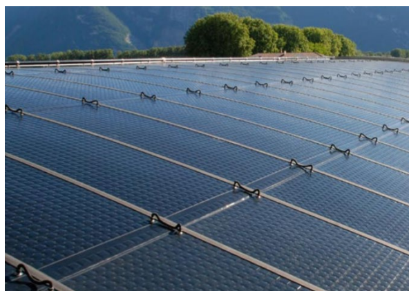
Abbildung 35: Unverglaste selektive Flachkollektoren (Energie Solaire, 2020)
