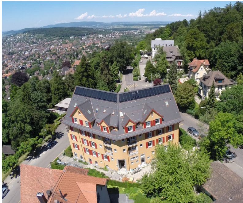
Abbildung 36: Bei der Renovation des Studentenheims Justinus-Haus in Zürich wurden 70.5 m 2 unverglaste Absorber auf dem Dach installiert, mit denen die 6 je 380 m langen Erdsonden regeneriert werden können. Bild © kämpfen zinke+partner
