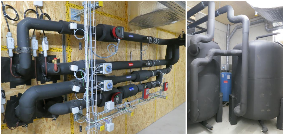
Abbildung 18: Hydraulik Sekundärseite mit Zuleitung zu dem technischen Speicher
