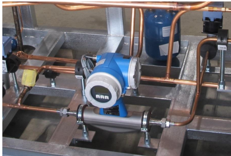
Abbildung 76: Montage des Durchfluss-Messgeräts
