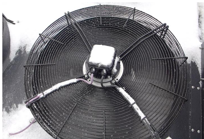
Abbildung 38: Verdampfer im Winterbetrieb während Abtauung
