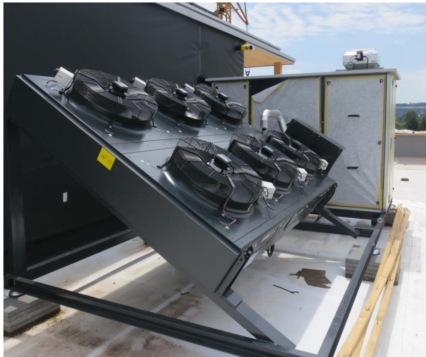
Abbildung 15: Positionierung der Wärmepumpe inkl. Ausseneinheit (Verdampfer / Verflüssiger je nach Betriebsart)
