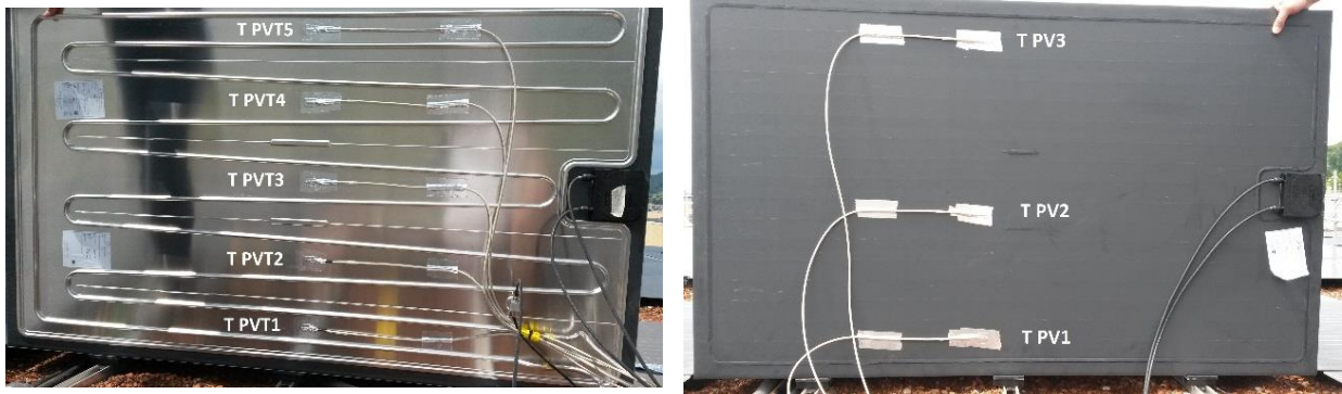
Abbildung 31: PVT Modul und PV Modul mit rückseitigen Temperatursensoren ausgestattet
