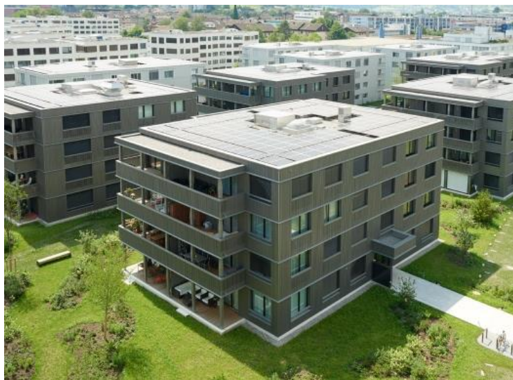
Abbildung 34: Ein Teil der mit PVT-Kollektoren belegten Mehrfamilienhäuser im Baufeld 3 des Suurstoffi Areals in Rotkreuz. (Bild: Zug Estates AG)
