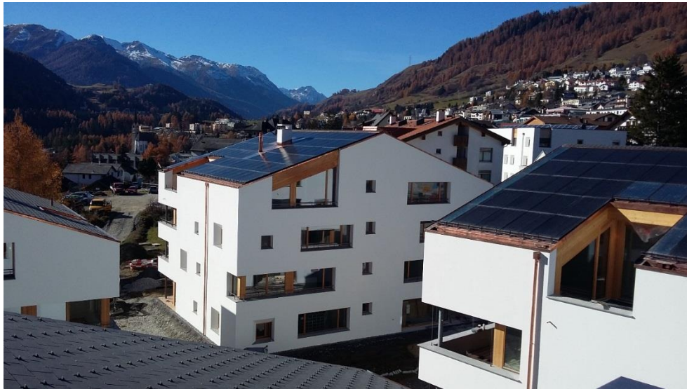
Abbildung 40: Überbauung Sotchà in Scuol, Ansicht auf Gebäude B (PVT) mitte; rechts das Gebäude D mit PV, welches nicht baugleich und daher nicht Bestandteil des Pilot- und Demonstrationsprojektes ist.
