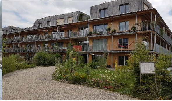
Abbildung 28: Ansicht von Gebäude B mit Einzeldächer 1-3
