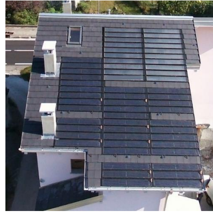
Abbildung 6: Nicht-abgedeckte Kollektoren als Dachziegel; links: Produkt MS 5 2Power der Firma PA-ID (Deutschland), (Bild: Bedachungshandel Tritschler AG); rechts: EY-Hybrid von Energyntegration (Italien), (Bild: Energyntegration S. r. l.)
