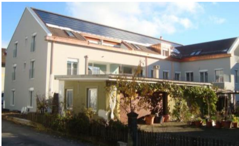
Abbildung 42: Büro- und Wohngebäude der Hässig Sustech GmbH in Uster (Bild: Hässig Sustech GmbH)
