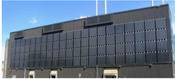
Abbildung 11: Luft-PVT-Systeme „SolarDuct PV/T®“ (links) und „SolarWall PV/T®“ (rechts) der Firma Conserval Engineering (Bilder: Conserval Engineering)
