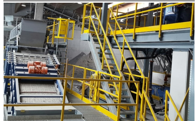
Abbildung 6: Von LAB Geodur realisierte Anlage am Standort der KVA Linth zur nassmechanischen Rückgewinnung von Metallen aus der Feinschlacke <2 mm. Oben die Prinzipskizze und unten die installierte Anlage.
