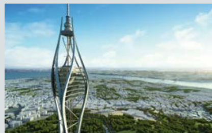
Hochfrequenztechnologie realisiert am neuen Fernsehturm Çamlica in Istanbul.
