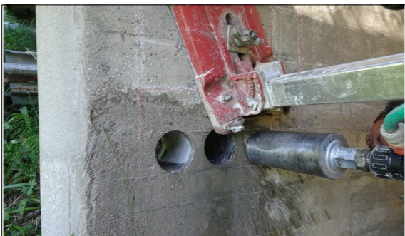
Entnahme von Bohrkernen Eigene Darstellung
