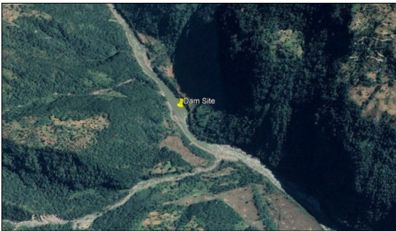
Google Earth Ansicht des Dammstandorts (Blickrichtung Flussaufwärts) "Aufgabenstellung BA FS 2020: Wasserkraft Projekt in Nepal"
