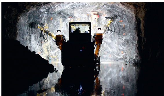
Ortsbrust mit Bohrjumbo RT 414
