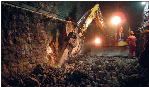
Ausbruch der Elemente im Tunnel
