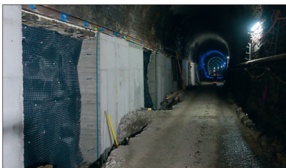
Pilgerschrittverfahren im Tunnel bei einseitiger Ausführung
