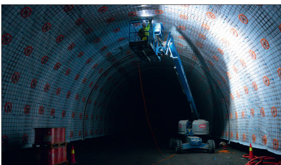
Abdichtungsarbeiten
