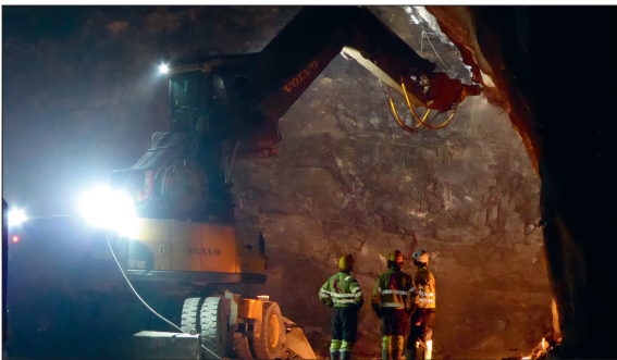
Das Nachprofilieren erfolgt mit einem Hydraulikbagger und einem Meissel und kann je nach Verlauf der Sprengung sehr aufwendig sein.
