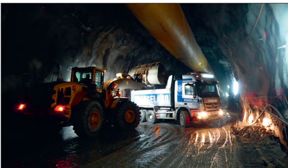
Ein Radlader belädt einen Lastwagen für die Schutterung des Ausbruchsmaterials aus dem Tunnel.
