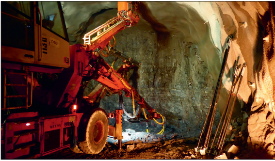
Die Erstellung der Bohrlöcher mit dem Bohrjumbo ist einer der zeitaufwendigsten Vorgänge im Vortrieb.
