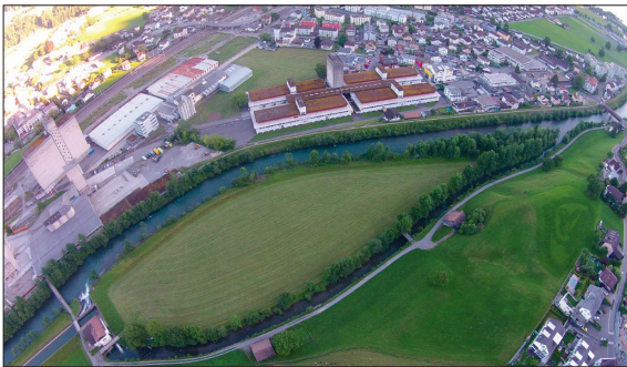
Projektgebiet (Blickrichtung Süden): Kraftwerkszentrale (links) und Zusammenfluss Muota sowie Unterwasserkanal (rechts). Eigene Flugaufnahmen 8.6.17
