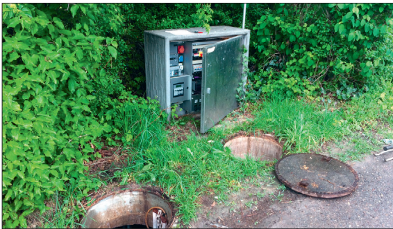
Bestehendes Abwasserpumpwerk Gfenn
