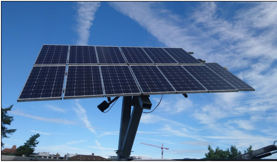
Abbildung 1: Photovoltaikmodule auf dem Dach des SPF Eigene Darstellung
