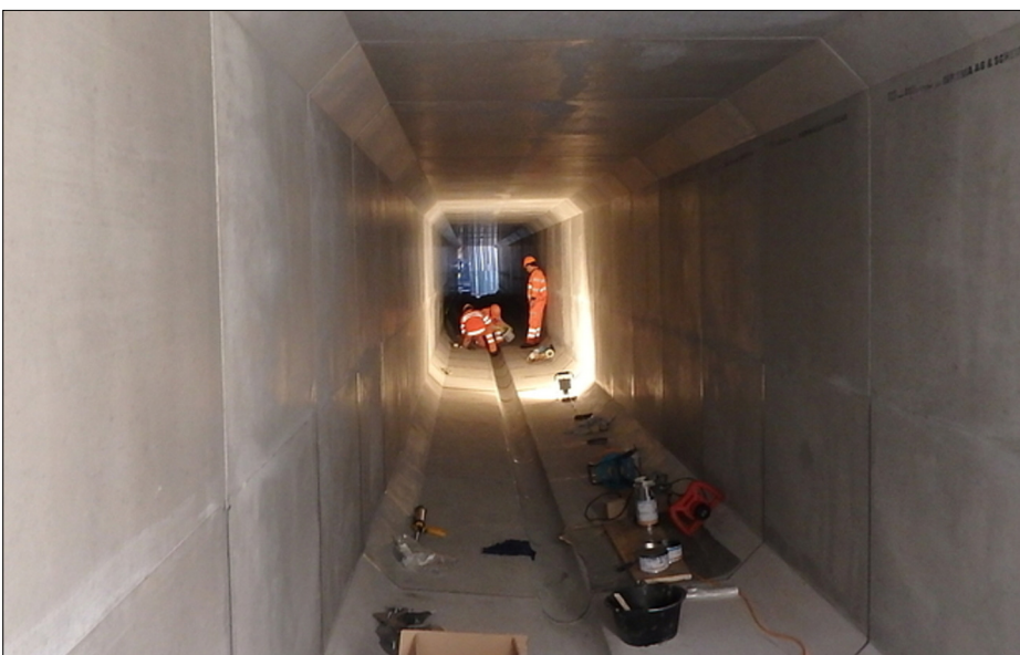
Fertig eingebauter Kanal mit vorgefertigten Elementen. (Quelle: Die Spezialelemente AG)
