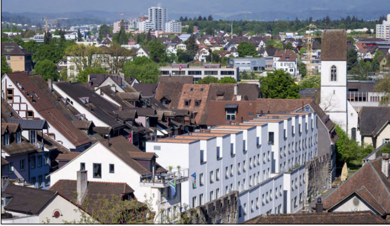
Neubau in Lenzburg mit positiver Auswirkung auf das Ortsbild STPC-Eitelbuss & Partners AG ( www.stpc-re.com )
