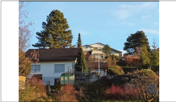
Gebäude für Sanierungskonzept in Grüti, ZH
