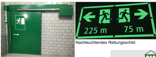
Querschlagstüre als Schiebetüre
