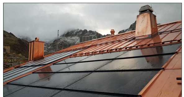
Solarthermiekollektor (links) und PV-Anlage (rechts) Eigene Darstellung
