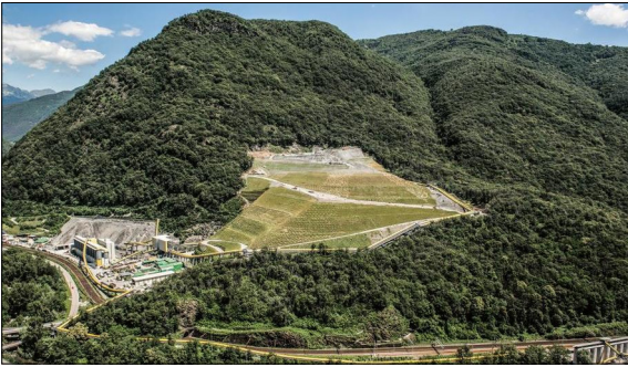
Depot Ausbruchmaterial Ceneri Basistunnel in Sigrino, Kanton Tessin (CH) (Seitz, 2020)
