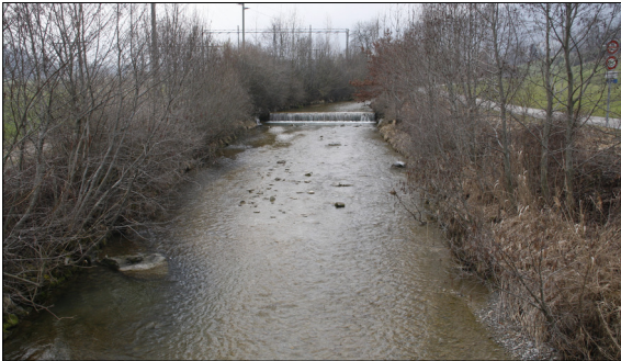
Kanalisiertes Fluss Gürbe Schaubildrichtung Süden Flussaufwärts
