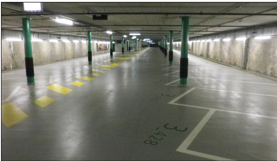
Tiefgarage in Zürich Eigene Darstellung
