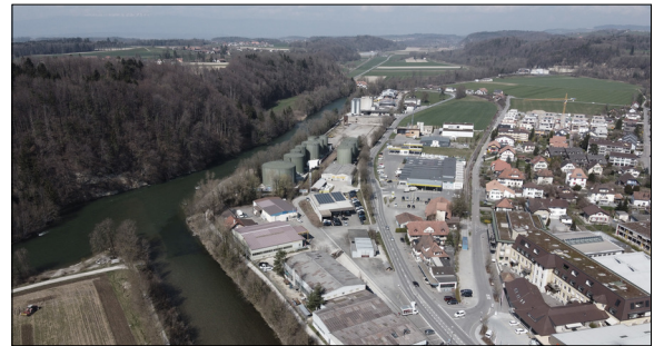
Luftaufnahme Mündungsbereich (Aufnahme 19.03.2020) Panorama, AG für Raumplanung, Architektur und Landschaft
