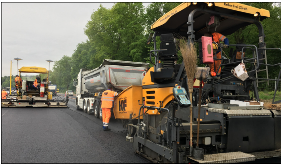
Belagseinbau Autobahn, Bülach (klassischer Asphalteinbau)
