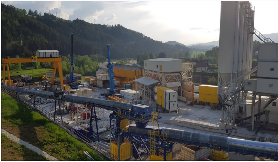
Blick auf den Installationsplatz (Tunnel Grautschenhof)
