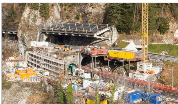
Installationsplatz Oelberg Süd Quelle: Marti Tunnelbau AG
