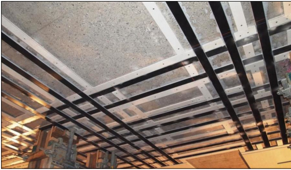
Verstärkung einer Stahlbetondecke mittels CFK-Lamellen. [Quelle: S&P, Anwendungsbereiche von CFK]
