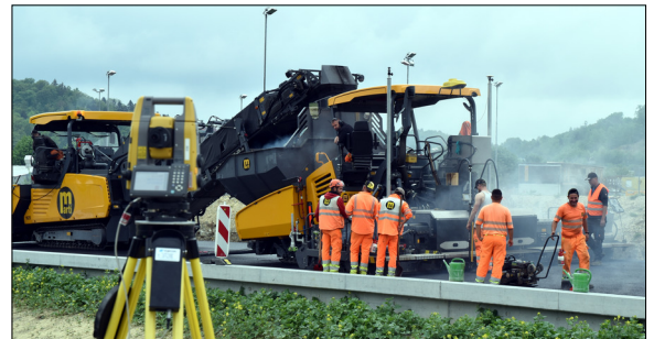
Maschinengesteuerter Belagseinbau Eigene Darstellung
