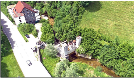
Luftaufnahme des Kraftwerks Tüfenhof in Wald Eigene Darstellung
