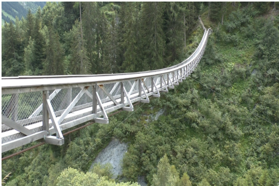
Die Hängebrücke in Curaglia GR wurde als Ersatz für einen zerstörten Wanderweg gebaut.
