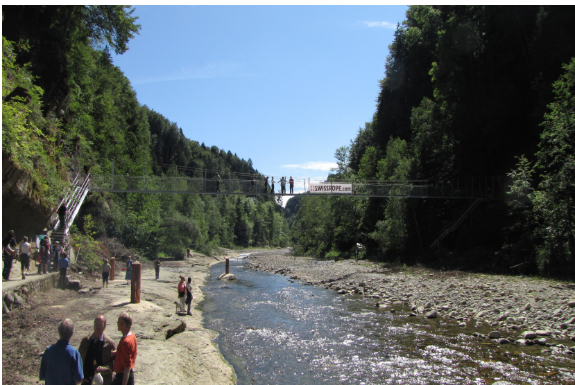
Im BLN-Gebiet «Schwarzenburgerland mit Sense- und Schwarzwasser-Schluchten» stellt die Hängebrücke eine Wegverbindung über den Sensegraben sicher.
