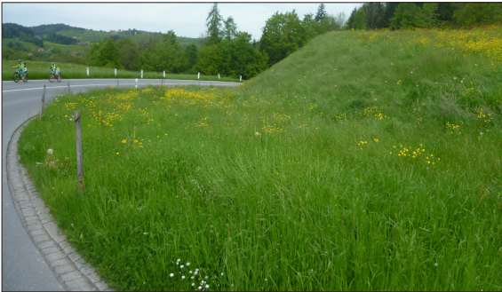
Sicherheitsdefizit: Kurve mit zwei unterschiedlichen Radien im Bereich Mittelholzweid
