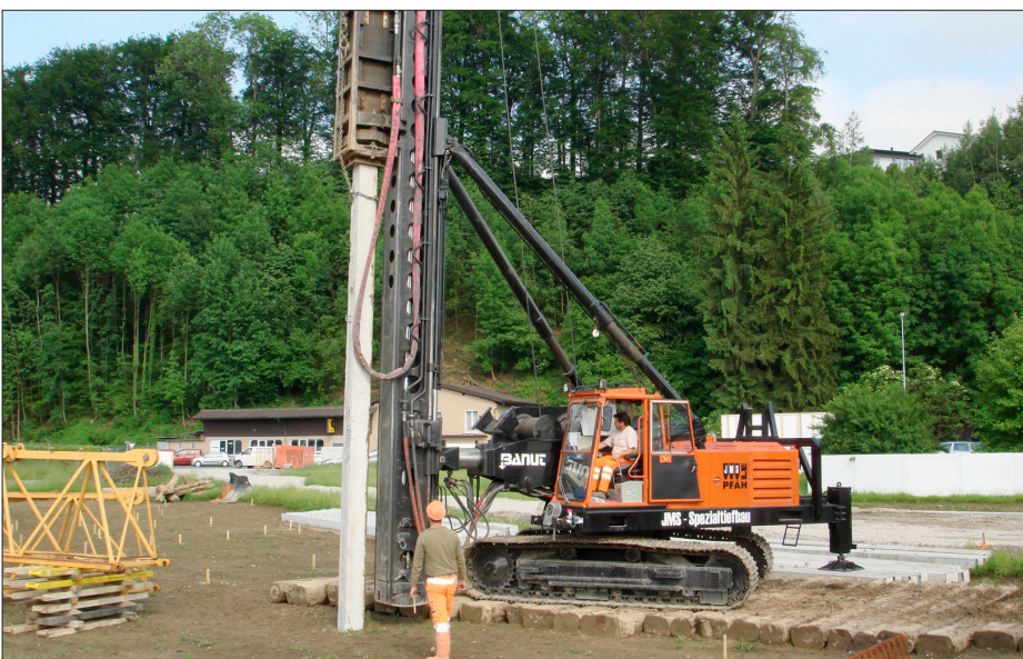
Rammgerät der Firma JMS-RISI
