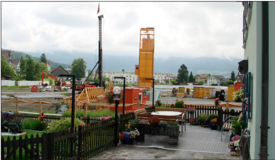
Sicht von angrenzendem Gebäude auf die Baustelle
