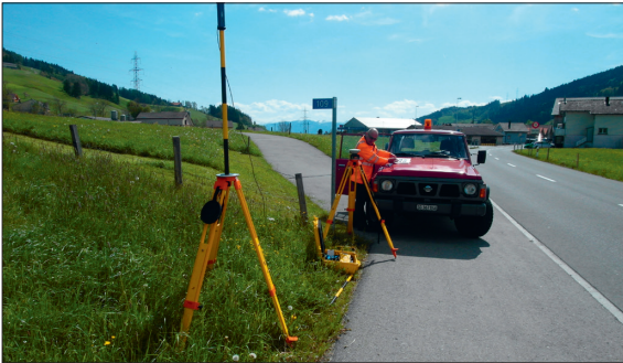
Aufbau der GPS-Basisstation mit anschliessender Georadar-Untersuchung im Projektbereich
