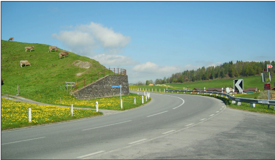
Heutige Situation am Flucht-Rank: ungenügende Sichtweiten und zu kleine Radien
