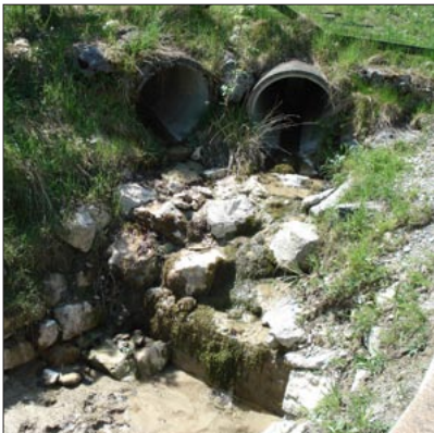
Einlauf bestehender Geschiebesammler
