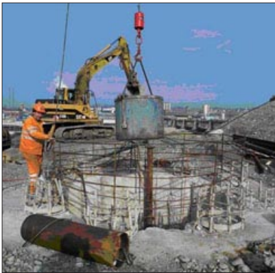
Bauarbeiten Horizontalfilterbrunnen
