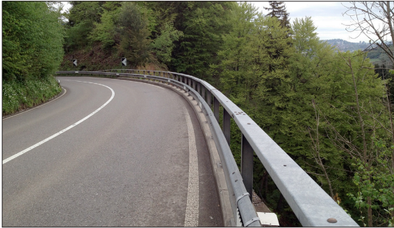
Bestehende Schneentladestelle im Bereich Kurve 1
