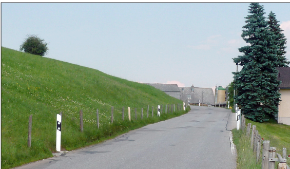
Die zu engen Kurvenradien werden in diesem Bereich korrigiert.
