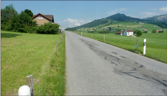
Der Belag musste schon öfters ausgebessert werden; hier der untere Bereich der Strasse, in Fahrtrichtung Eggerstanden.
