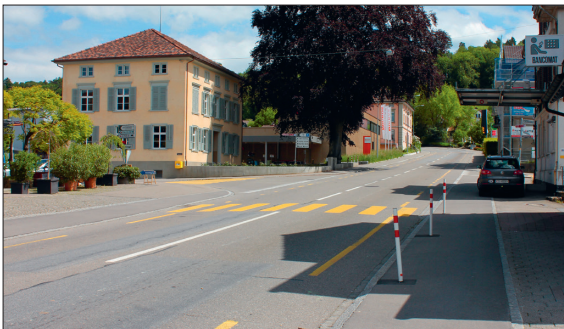
Mangelhafte Querungstelle für Fussgänger
