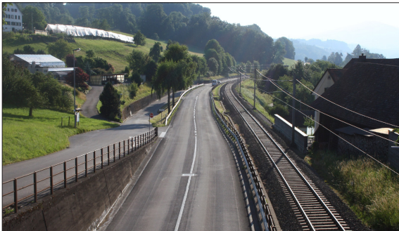
Bestehender Zustand der Einmündungen in Bollingen
