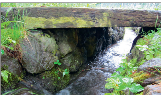
Foto des bestehenden verbauten Gerinnes mit Holzbrücke
