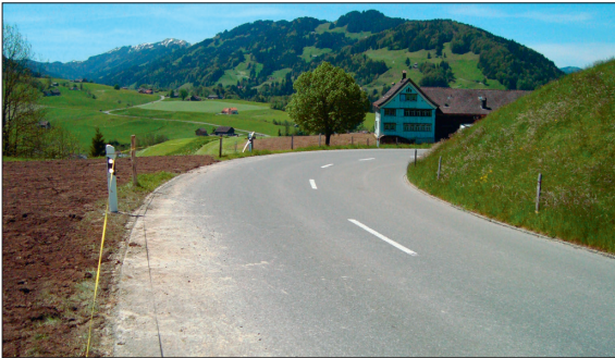
Ungenügende Anhaltesichtweite der bestehenden Strasse im Bereich Böschel
